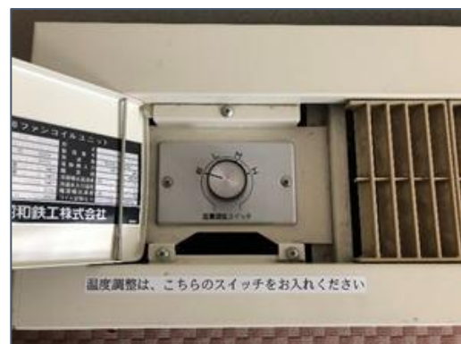
ファンコイルの風量調整ダイヤル
